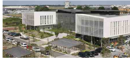
L'hôtel Sheraton est ouvert depuis janvier au sein de ce pôle tertiaire situé sur la zone aéroportuaire. photos Fabien Cottureau / « SO »
