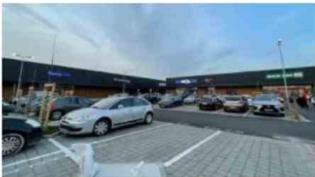
La nouvelle zone commerciale, rue François Mitterrand est complète.
